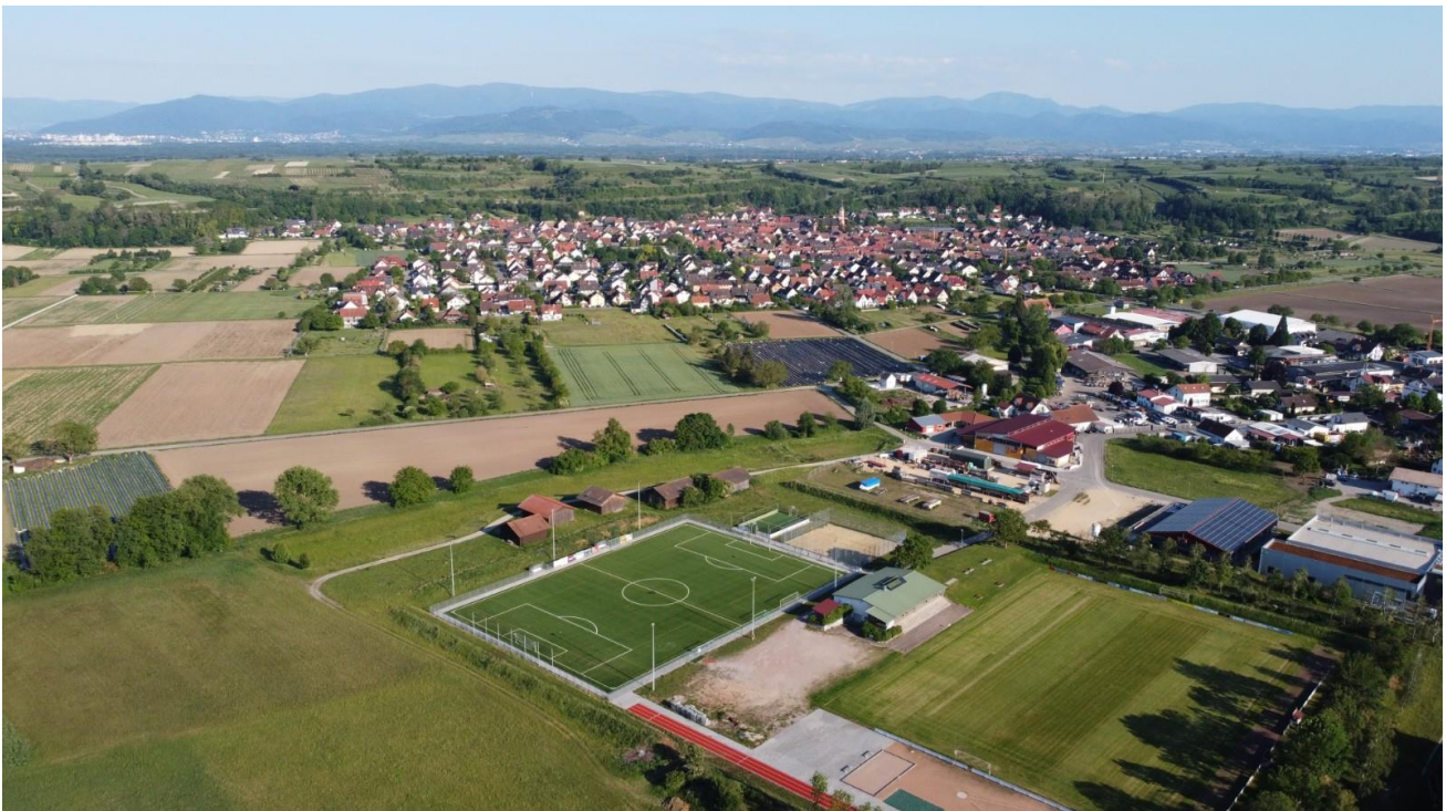
Abbildung 10: Luftbild der Gemeinde Merdingen. Das Gewerbegebiet liegt im Vordergrund rechts, Foto: Mark Armbrust
